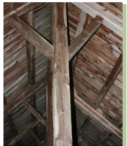
Photo 6 – Ferme et poinçon type de l'ensemble des bâtiments. Dans l'ensemble, la reprise de la toiture ne concerne que la couverture.
